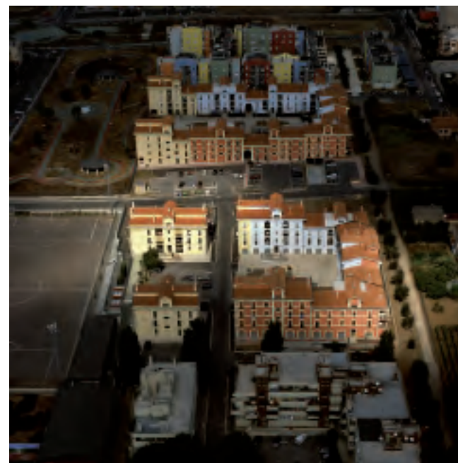
Ponte di Nona, Portoghesi
