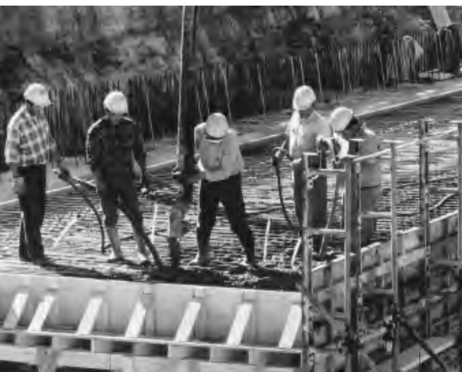
Lavori sulla linea Palermo-Punta Raisi In alto il Cantiere Pizzi di Foglia sulla Direttissima Roma-Firenze (1973)
