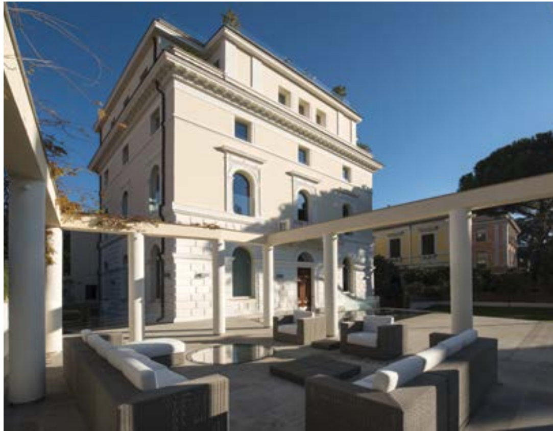
Menzione: Italiana Costruzioni Headquarters – Roma Progettisti: Westway Architects associazione professionale – Arch. Luca Aureggi, Arch. Maurizio Condoluci Committente: Italiana Costruzioni S.p.A. Impresa esecutrice: Italiana Costruzioni S.p.A.
