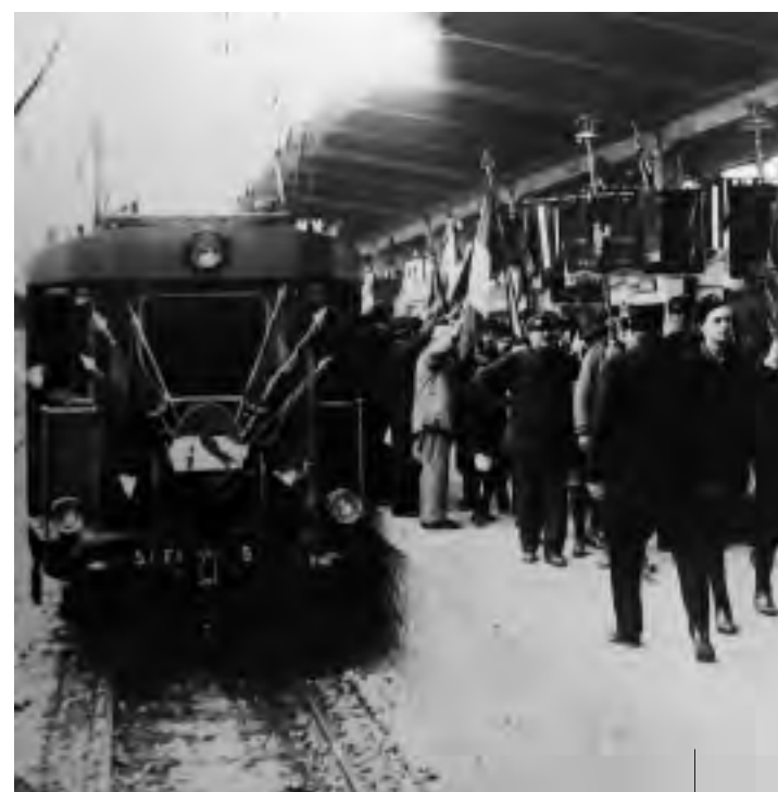
Il 10 agosto del 1924 viene inaugurata da un convoglio partito dalla stazione di Porta San Paolo la linea ferroviaria Roma-Ostia
