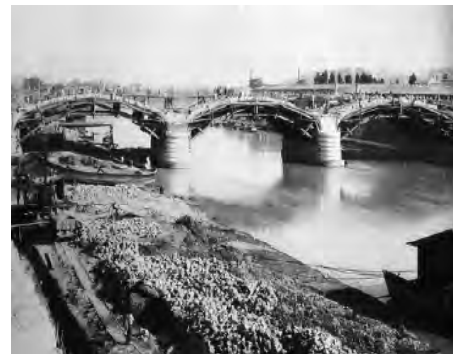
Ponte Regina in costruzione, 1889
