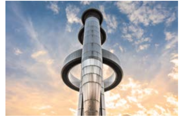
Alessandro Zompanti, Torre piezometrica Vigna Murata
