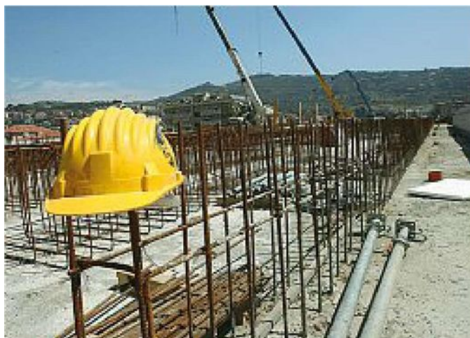
Paralisi Rischiano il blocco i cantieri edili di grandi, medie e piccole dimensioni perché non sempre si possono rispettare le distanze tra gli operai
