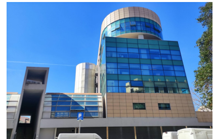
Edificio per mercato ed uffici - via Andrea Doria
