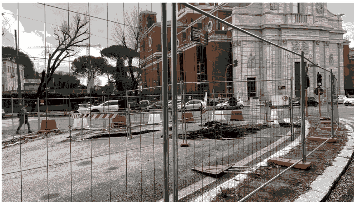
Un cantiere ai Parioli (repertorio)
