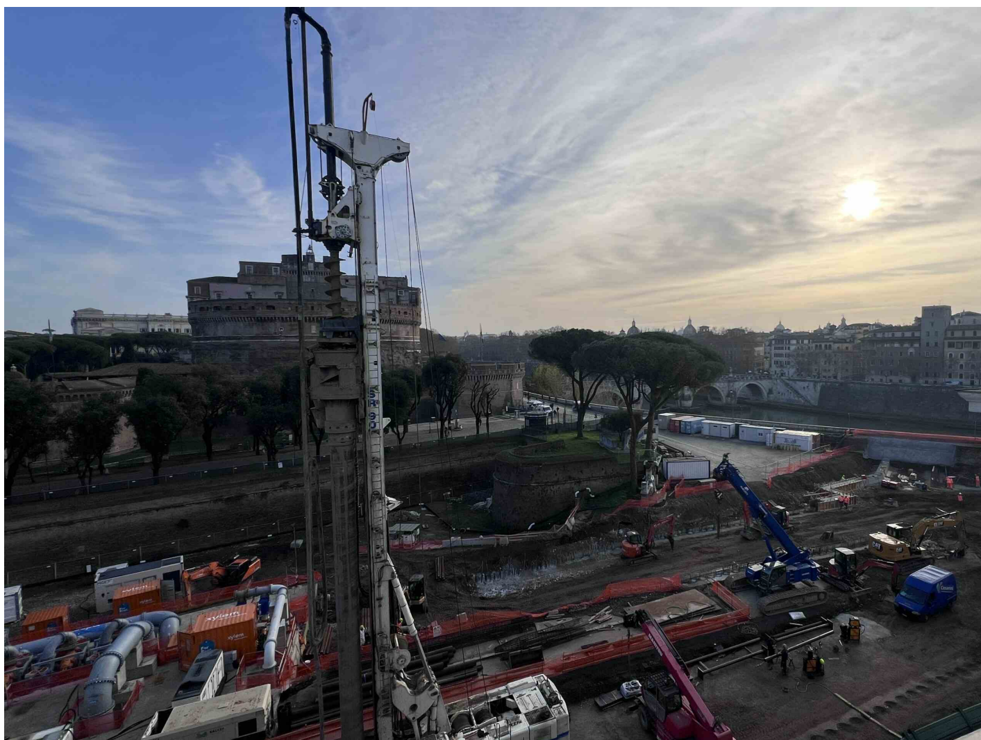
Il cantiere del sottopasso di piazza Pia per il Giubileo 2025
