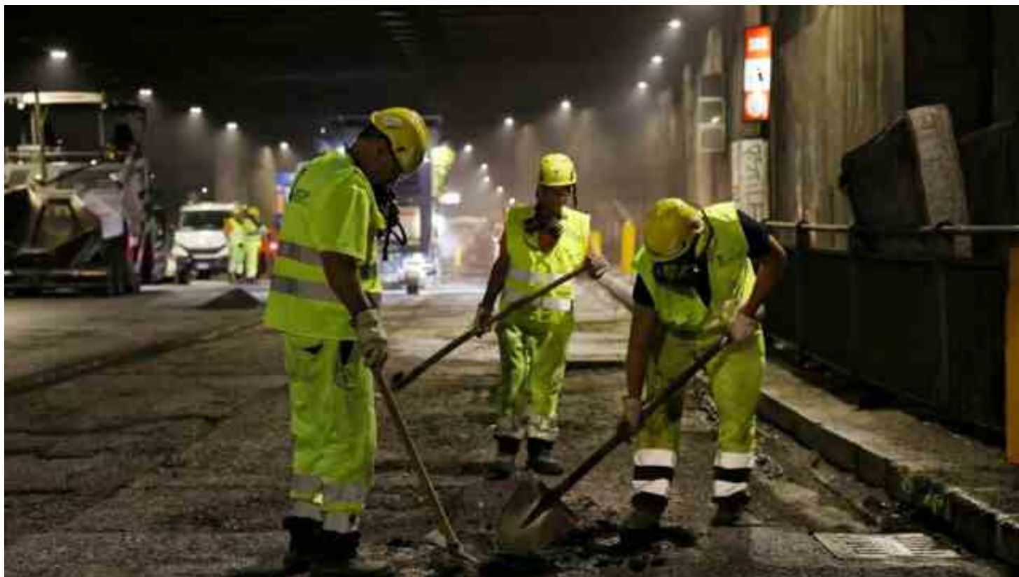
Operai al lavoro sulla viabilità di Roma nell'ambito degli interventi per il Giubileo 2025 (repertorio)
